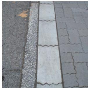
長辺はILB舗装や他舗装との取り付けを考慮してストレート形状とし、短辺は噛み合わせ効果のある波形の形状を有しています。ブロックの移動をおさえ、がたつきを防止します。
