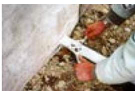
スキンに埋め込まれている固定金具にストリップをボルトにより締めつけ、設置する。
