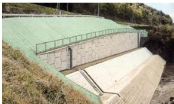
現地盤が軟弱であり、地下水位の影響もあるため、面状補強材(ジオテキスタイル)で砕石を巻き込んで、下部地盤の地盤改良処理を行いました。上部構造、下部構造とも補強土とすることによって、全体の安定性を高めた工事例です。
