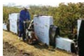
ストリップと直角方向に転圧を進め、スキン側1.0mはスキンの押し出し防止のため、小型転圧機(コンパクター等)で行う。これ以外は大型機械を使用して転圧を行う。
