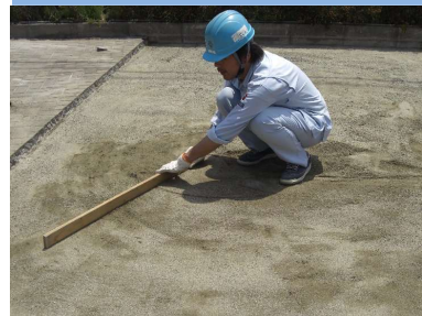
3. クッション砂の敷き均し
