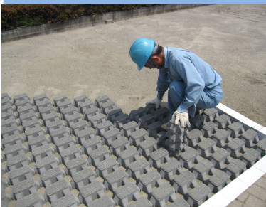
4. 美緑ブロック敷設
