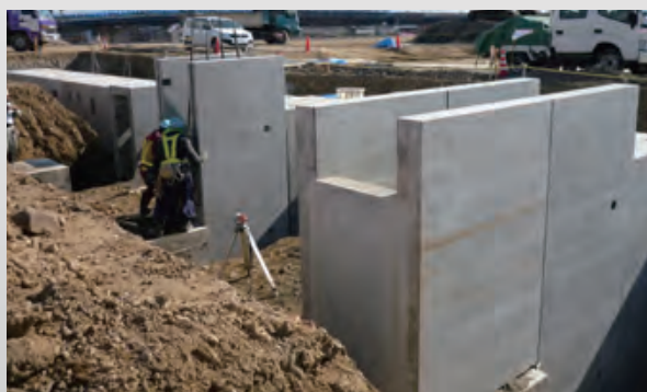
U型構造の部材を使用して、昇降部のプレキャスト化も対応できます。
