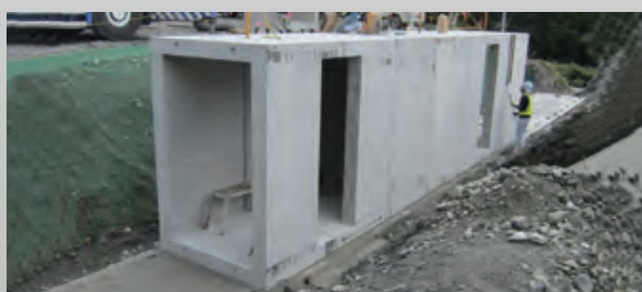
U型構造の部材を使用して、昇降部のプレキャスト化も対応できます。
