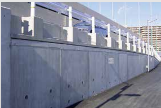
▲プレキャストL型擁壁直上設置の事例
