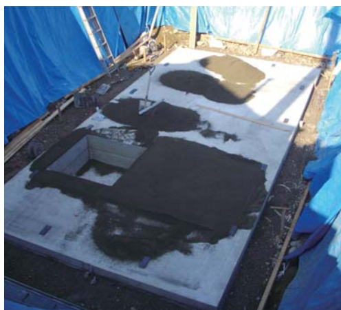
1 基礎コンクリート
