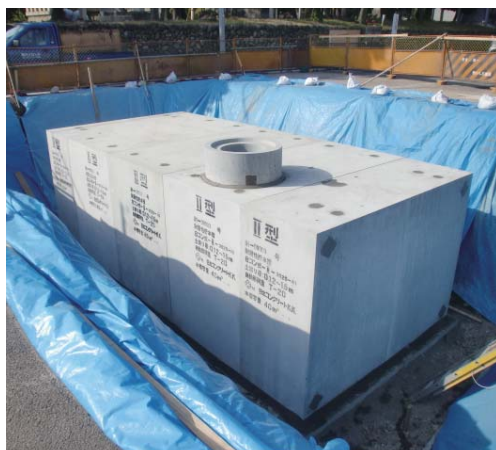
5 組立接合完了
