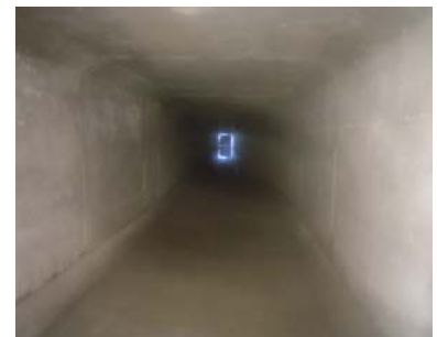
ボックスカルバート内部
