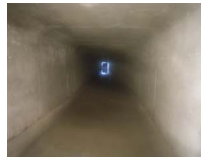
ボックスカルバート内部
