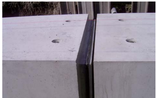
継手部が地震動を吸収します
