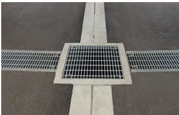
I型(愛知県安城市・グレーチング併用)
