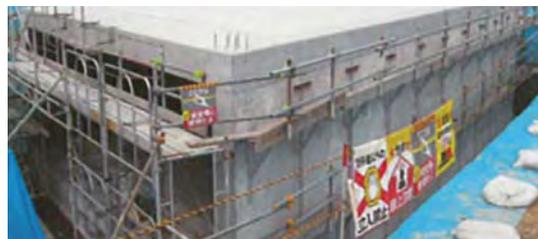
頂版隅角部及び底版部にコンクリートを打設し完了。
