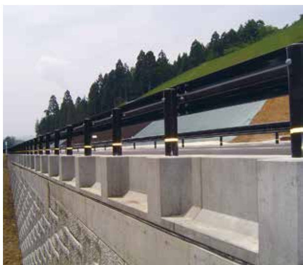
補強土壁直上設置の事例
