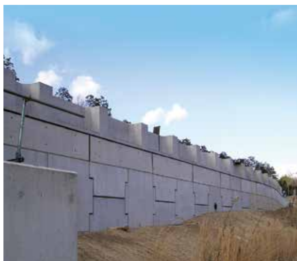
補強土壁直上設置の事例
