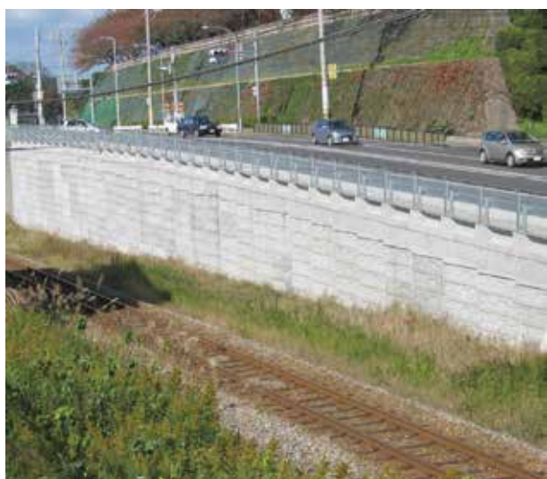
超軽量盛土直上設置の事例
