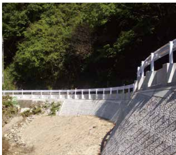
積ブロック直上設置の事例
