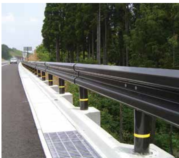
背面に側溝設置の事例
