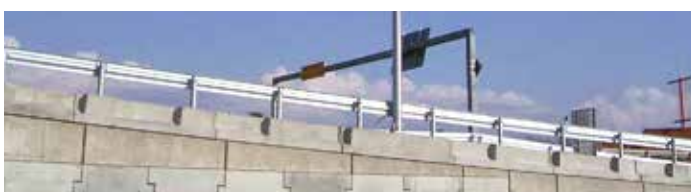
縦断勾配9%の施工実績例
