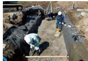
3 中詰材敷均し・締固め
