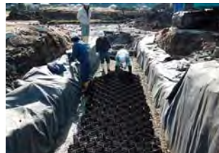
2 不織布(吸出し防止材)・グランドセル設置
