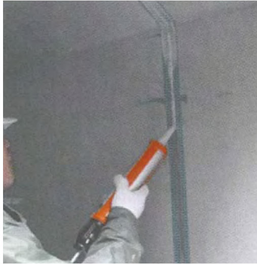
目地部への施工(内面から)
