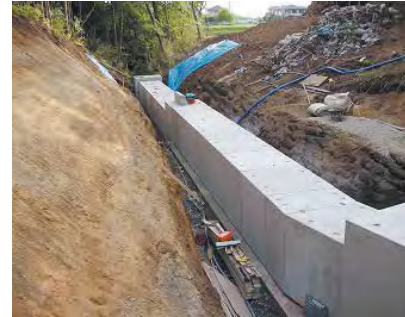
狭隘かつ落差工でのボックスカルバート搬送(横引)据付施工
