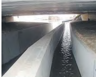
高架下の大型フリューム搬送(横引)据付施工
