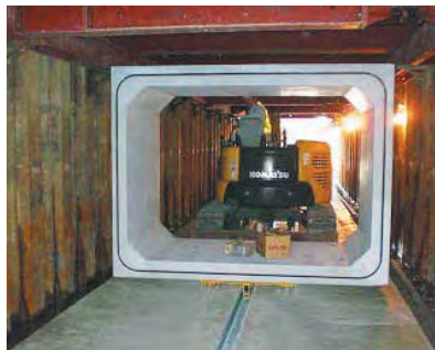
覆工版下でのボックスカルバート搬送(横引)据付施工
