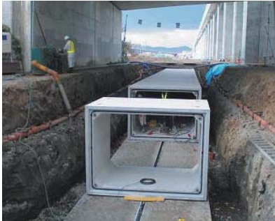
高架下のボックスカルバート搬送(横引)据付施工
