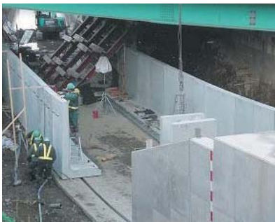
高架下のL型水路ブロック搬送(横引)据付施工
