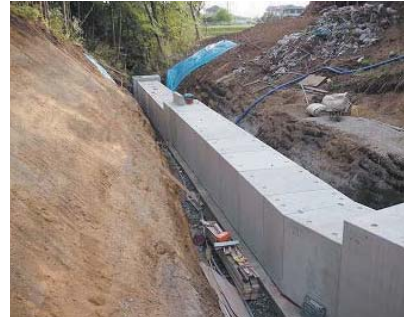
狭隘かつ落差工でのボックスカルバート搬送(横引)据付施工
