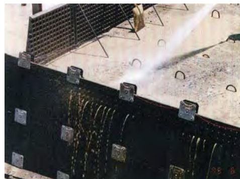
6 グリーンカット状況
