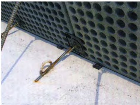
1 基礎上部組立状況
