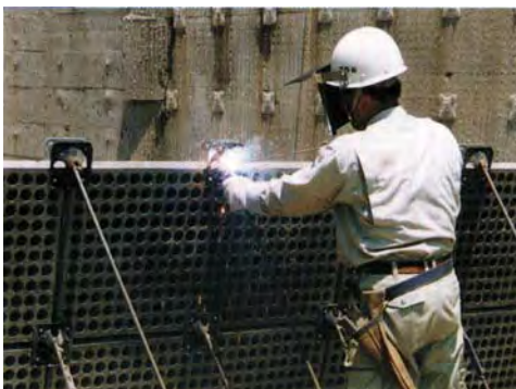
3 セパレーター溶接状況
