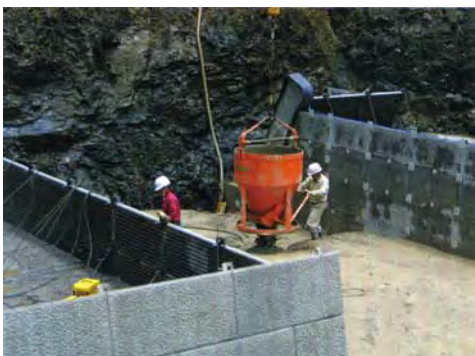
5 コンクリート打設状況
