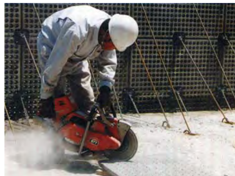
4 型枠パネル切断加工状況
