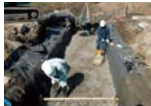
3 中詰材敷均し・締め
