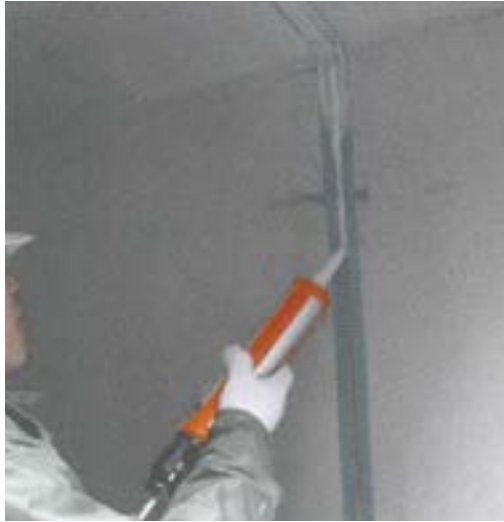
目地部への施工(内面から)
