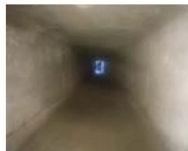
ボックスカルバート内部
